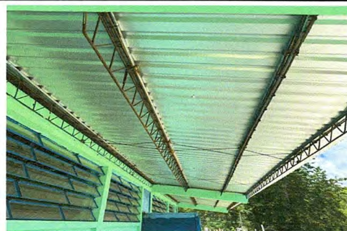
Foto 4: Cubierta de lamina.
