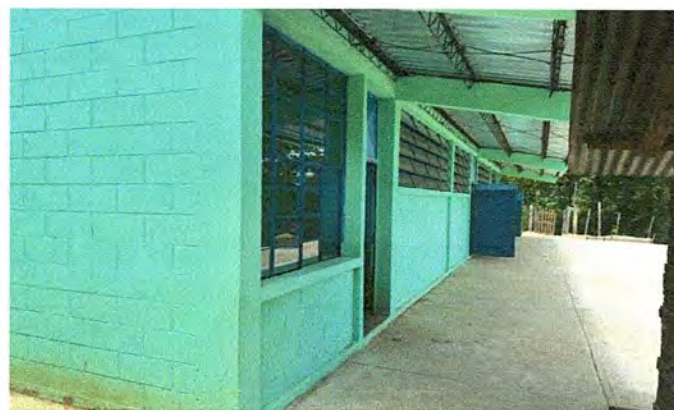
Foto 2: Pintura en muros interiores y exteriores.
