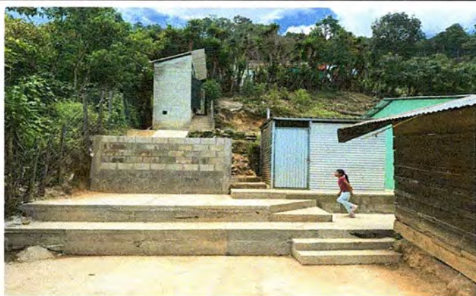
Foto 1: Reparación y sustitución de Área de cocina.
